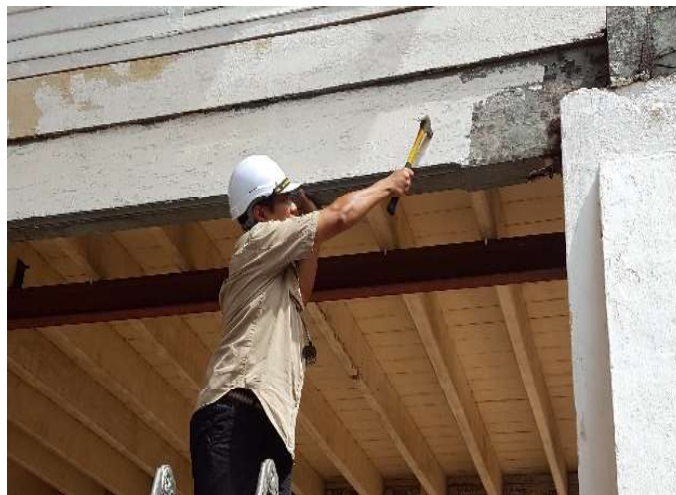
Rajah 6: Gambar menunjukkan konservator membuat ujian ketukan bagi mengenalpasti kepaduan kayu. Sekiranya berbunyi lompang, menunjukkan bahagian tersebut tidak padu dan mungkin terdapat rongga atau pereputan dalaman.
